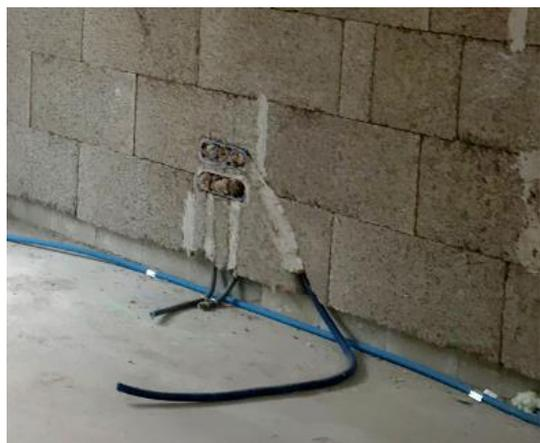
La réalisation des saignées (rainurage) pour les réseaux (électricité, eau...) se fait à l'aide d'une rainureuse et d'une scie cloche adaptée.
