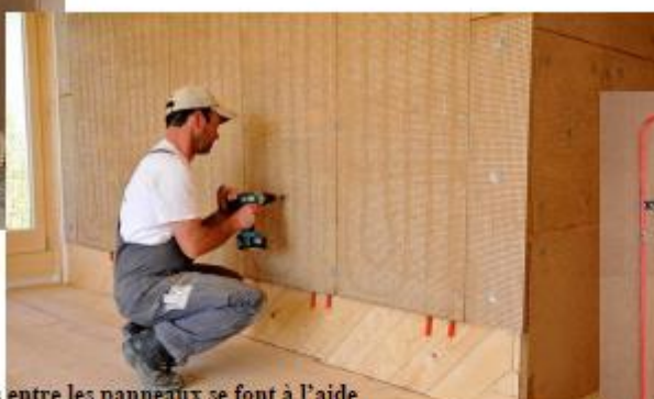
Les joints entre les panneaux se font à l'aide des toiles de verre fines.
