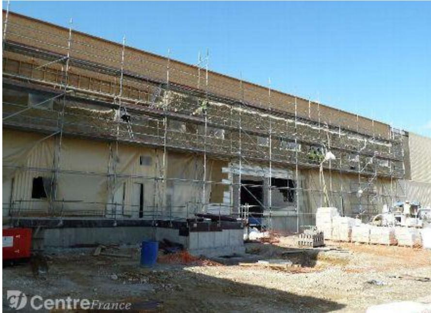
Le béton de chanvre est testé sur ce mur de 8 mètres de haut et de 300 m de surface, exposé au sud et au vent.
