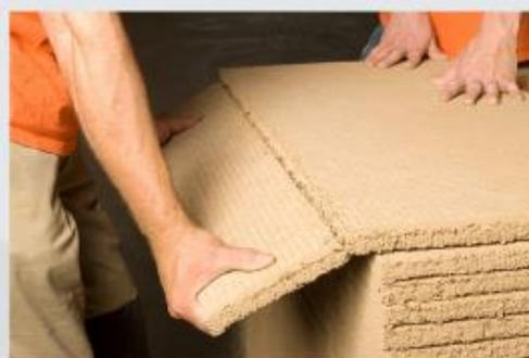
Découper le panneau en séparant des deux côtés le treillis d'armature au moyen d'un cutter et puis casser le panneau au-dessus d'un bord.
